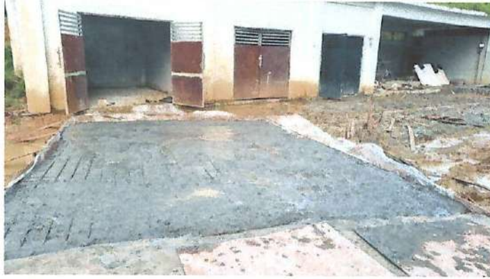
Pengecoran Jalan
