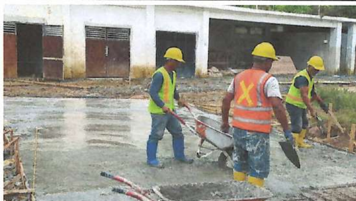
Pengecoran Jalan
